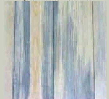
Hongo en Machimbre despues de colocacion
